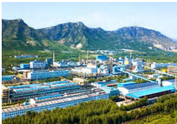
豫光金铅玉川厂区
