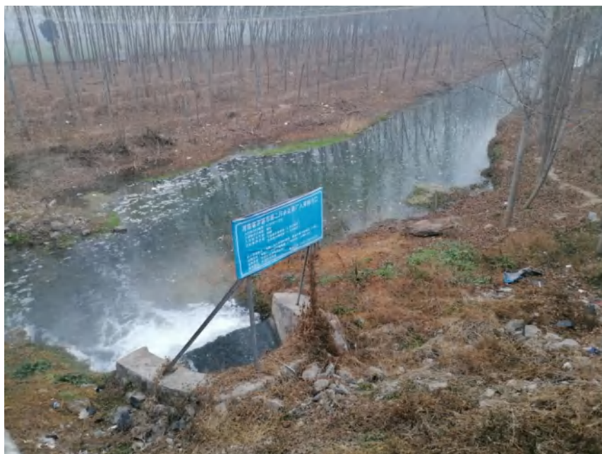
图 2.3-5 济源市第二污水处理厂排污口
