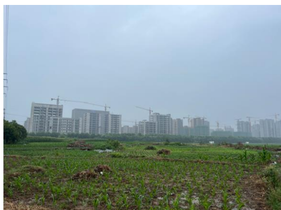
照片3-12 地块6现状（雨天调查）
